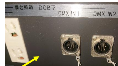
②下手DMXin及び③上手DMXin (受け部分オス)(C30と平行コンセントあり)
