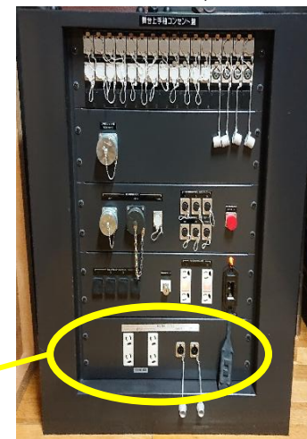
②下手DMXin及び③上手DMXin (受け部分オス)(C30と平行コンセントあり)
